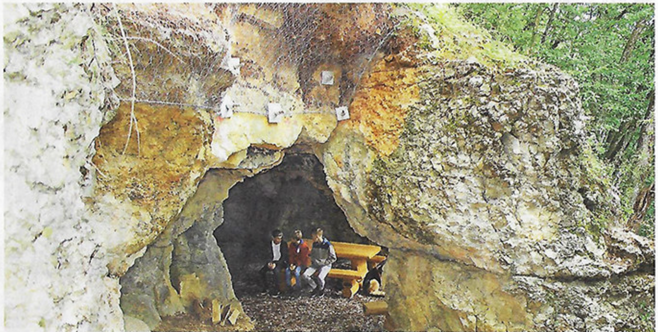
Im Fels verankerte Stahlnetze schützen vor Steinschlag und Felsabbrüchen.
